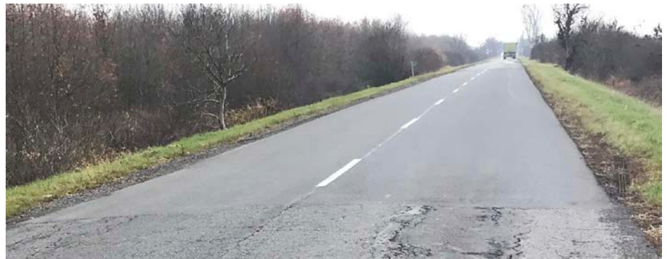
6. kép. Az elkészült javítás a munkaterület határával
