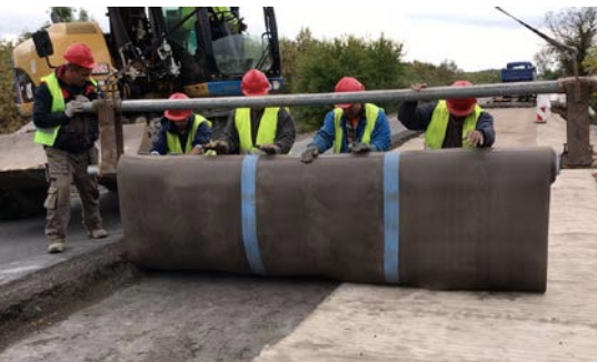
4. kép. CC8 terítése hosszanti irányban
